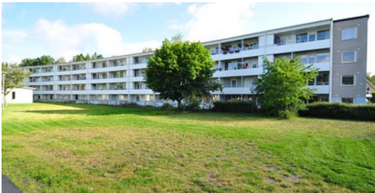
Vy över planområdet sett från Trädgårdsvägen mot norr.
