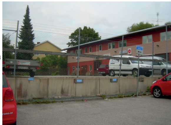
Mellan Vilunda 18:1 och parkeringsplatsen på Vilunda 1:548 finns en nivåskillnad på cirka en meter där en stödmur har anlagts.
