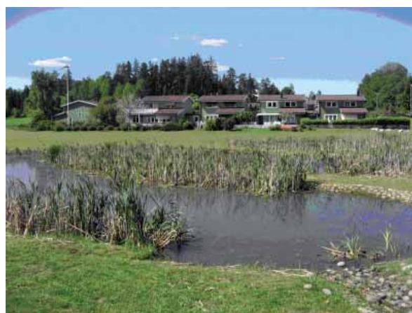
Dagvattendamm i anslutning till ett bostadsområde
