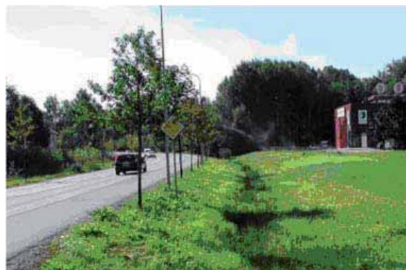
Exempel på svackdike
