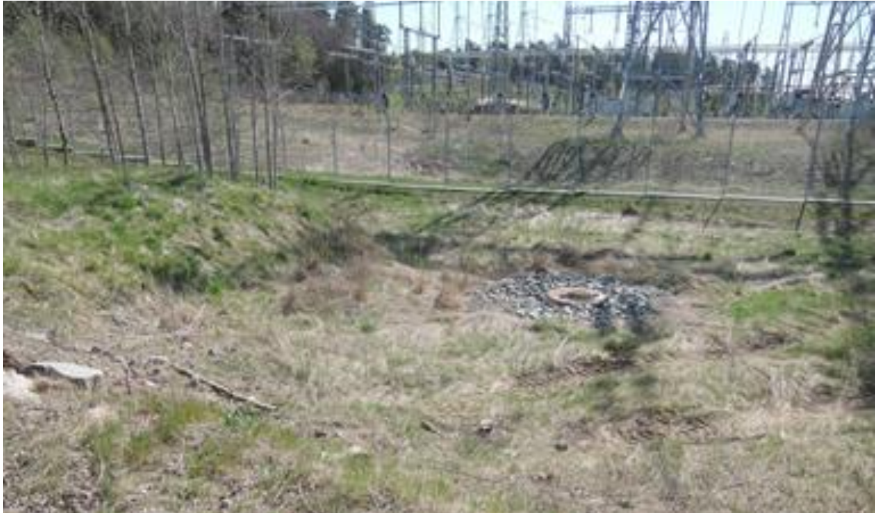
De befintliga dagvattenledningarna utlopp.
