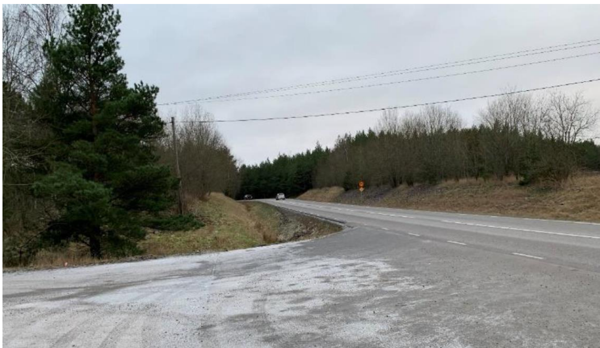
Korsningen Frestavägen/Torslundavägen sett söderut.
