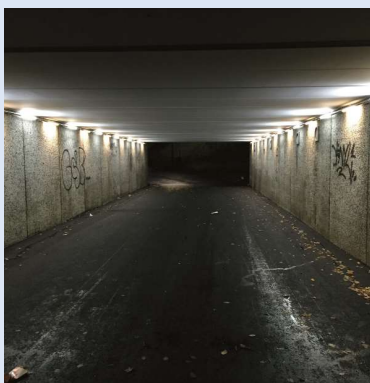
Gång- och cykeltunnel under Mälarvägen
