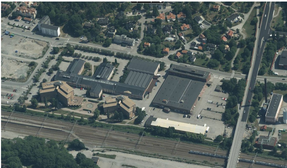
Ovan en flygbild över området sett västerifrån. Järnvägen närmast i bild och i bakgrunden Folkparksområdet.
