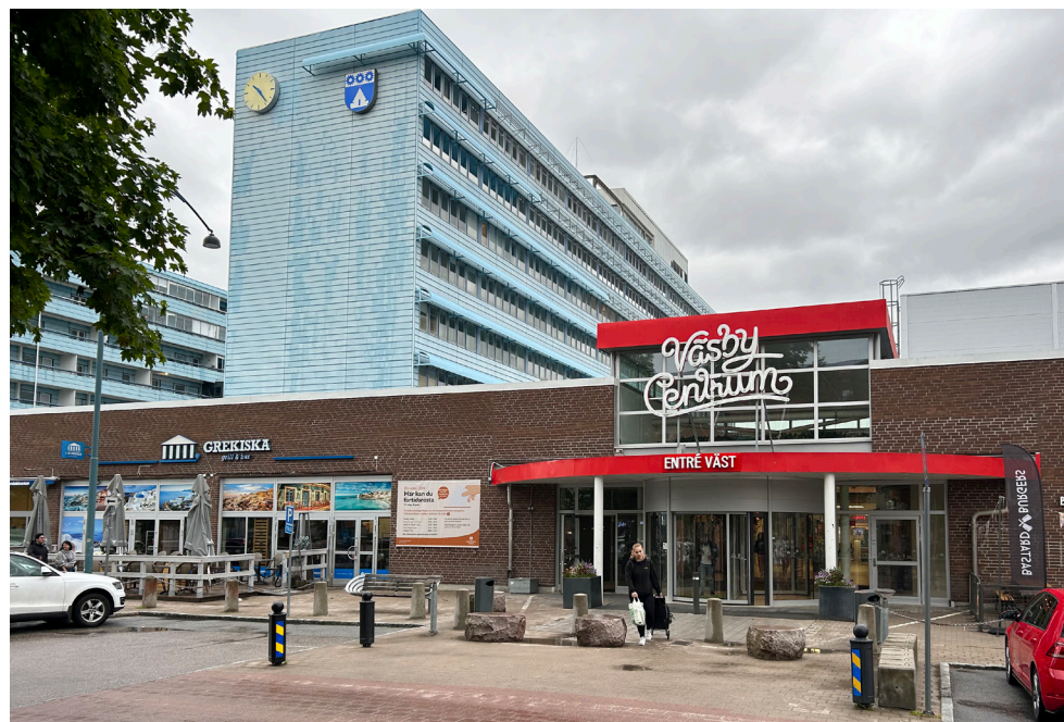
Centrumbyggnadens västra entré med blått skivhus i bakgrunden.
