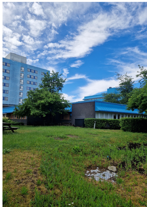
Byggnadens lågdelen har en stor grönyta ut mot Kyrkvägen.
