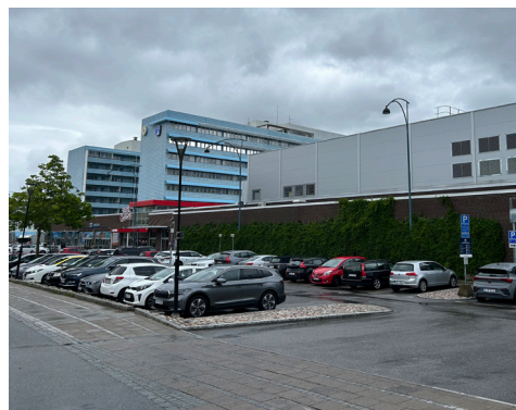
Skivhusen och centrum med påbyggnad mot entréplatsen vid Dragonvägen.
