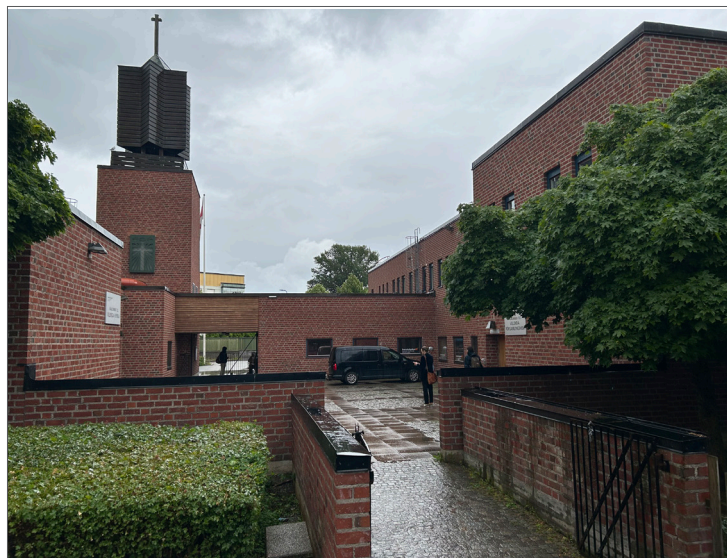
Kyrkcentrums innergård. Här syns murar som omringa gården samt sammanbinder kyrksalens byggnad med församlingshemmet.
