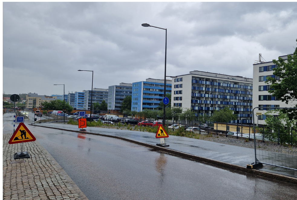
Skivhusen är 10st och placerade på rad längst Dragonvägen.
