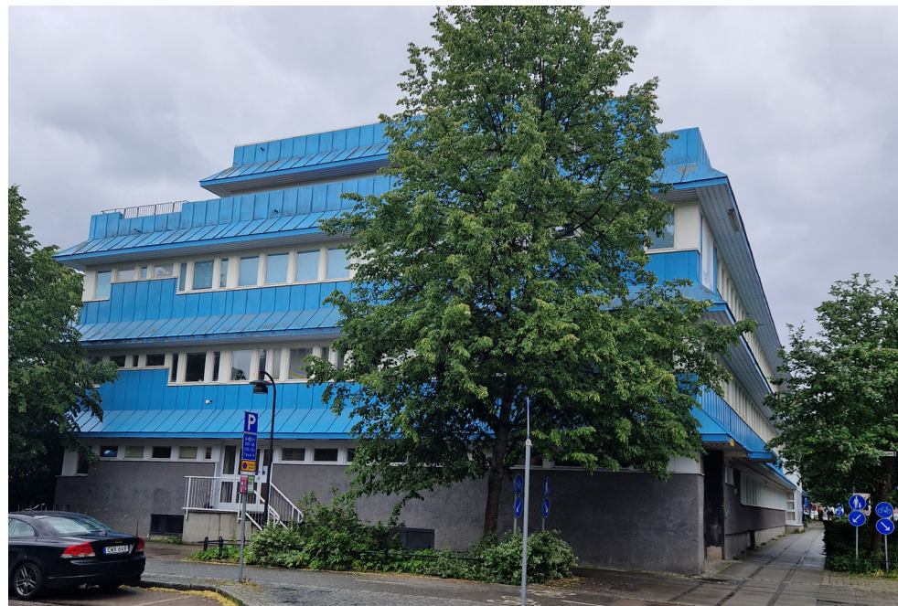
Högdelen sedd från korsningen Dragonvägen/ Kyrkvägen. Byggnaden har en stark blå kulör.
