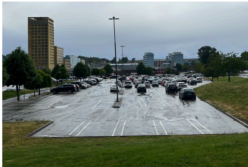
Centrumbyggnaden sett från norr med tillhörande parkeringsplats. Den låga volymen underordnas skivhusens siluettverkan, som upplevs tydligt i denna vy. Det guldfärgade Drabantehuset är ett nytt landmärke i centrum.
