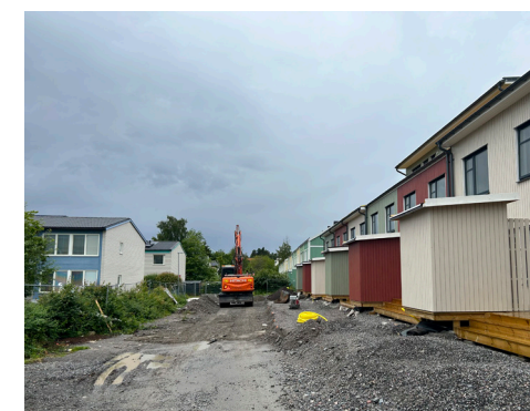
Stadsradhus avslutar Fyrklövernområdet mot söder.
